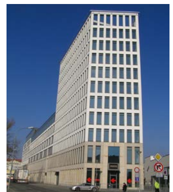
Administratives Gebäude Trinity, Brno, Tschechische Republik
